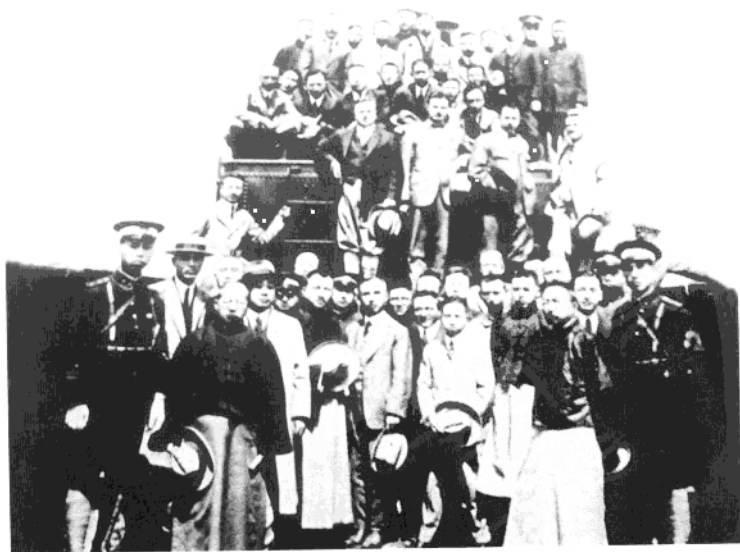
1904 年胶济铁路通车，火车第一次开进济南市
