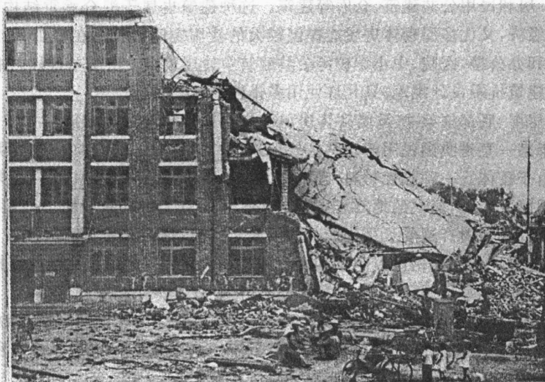
图 1.3 房屋变形缝一侧整体倒塌
