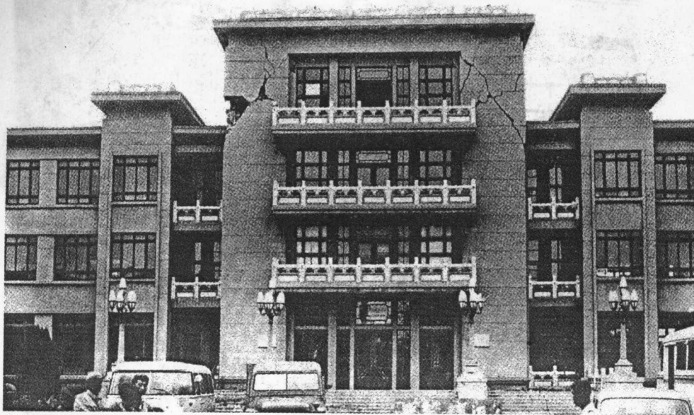
图 1.7 突出的 4 层小楼严重破坏
