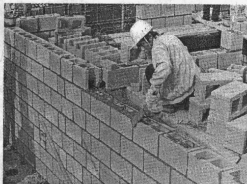
图 1.13 配筋墙体的现场施工
