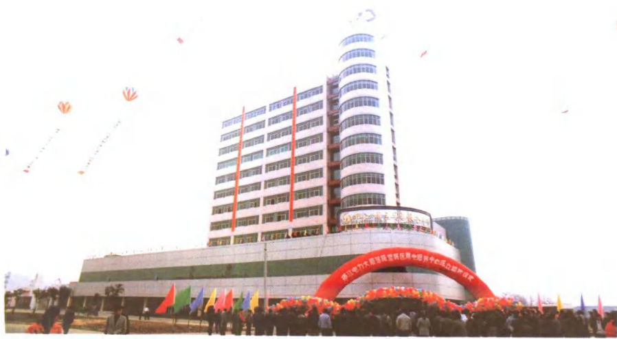
邗江县供电局办公大楼及供用电服务中心
