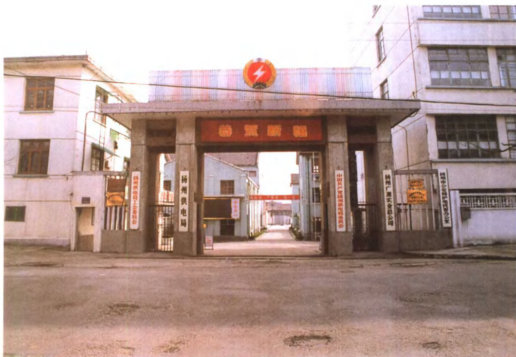
扬州供电局大门
