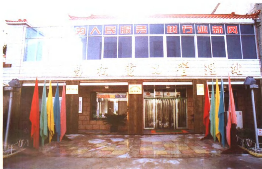
扬州供电局“为人民服务，树行业新风”乡镇电管站示范窗口——江都市昌松镇电力管理站
