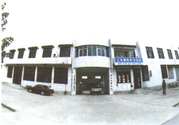
■ 局机关办公楼一角
