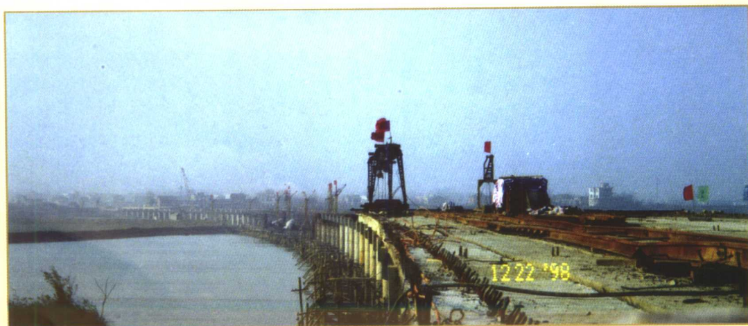
▲北港湖特大桥施工现场
