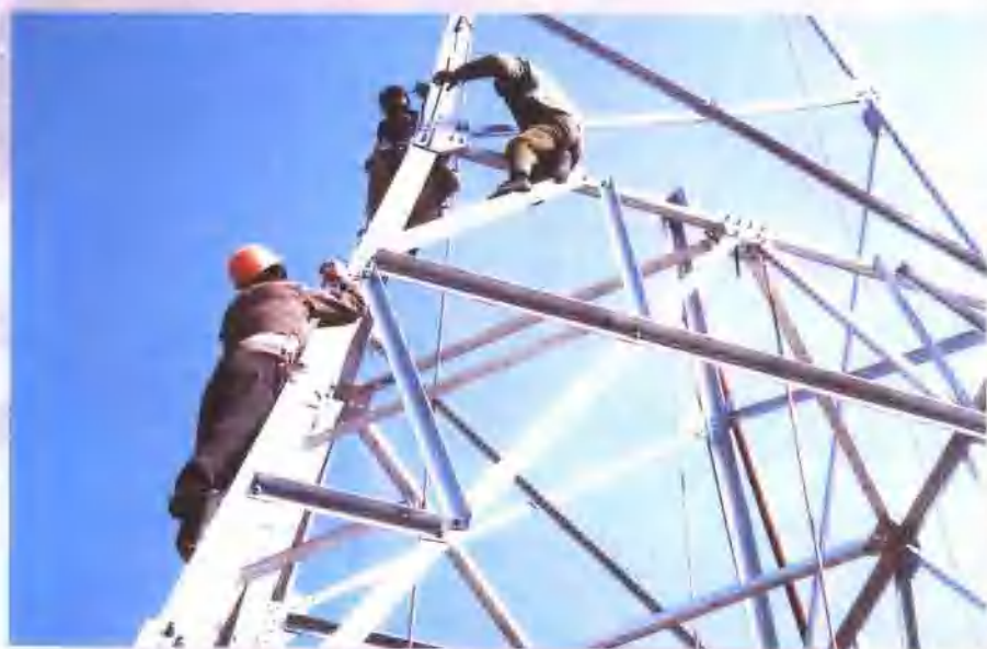
GSM八期扩容工程中施工人员紧张施工
