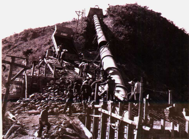
1986年建成的丙巷河倒虹吸工程
