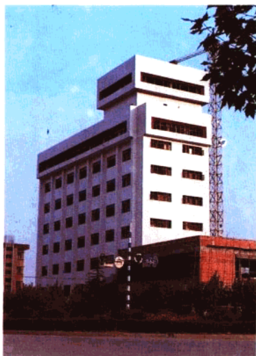
程控电话综合大楼
