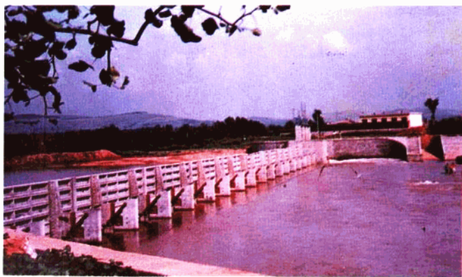
十字河自控翻板闸
