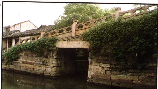
桥阶梯下筑桥洞 解决了交叉河道的过渡
