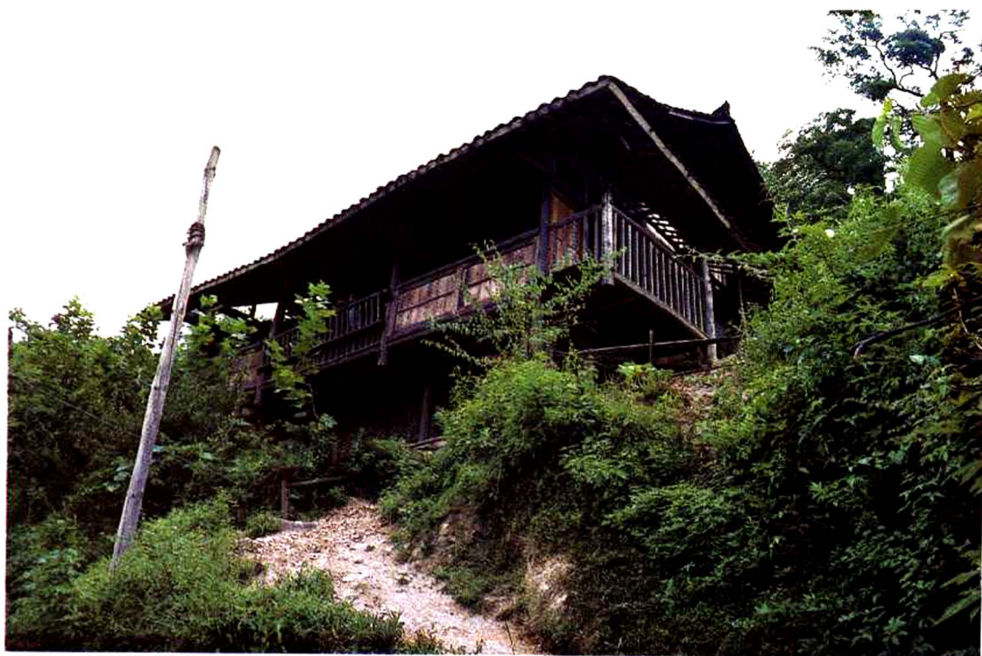
台江县台拱寨某宅大悬挑
