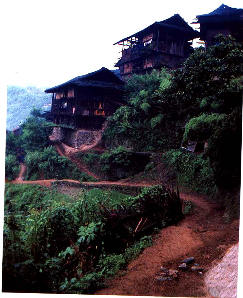
陡坡上的分层筑台
