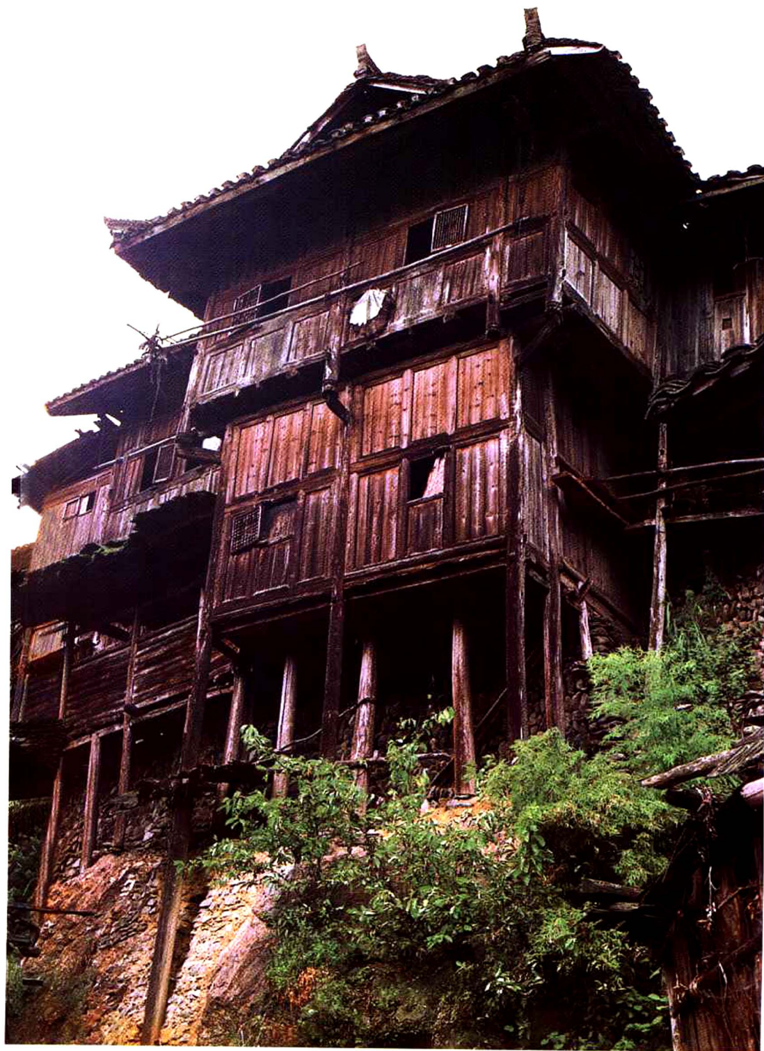
雷山县黄里寨某宅适应地形的山面处理
