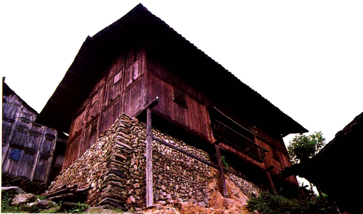
雷山县黄里寨某宅筑台、悬挑、吊脚三结合手法
