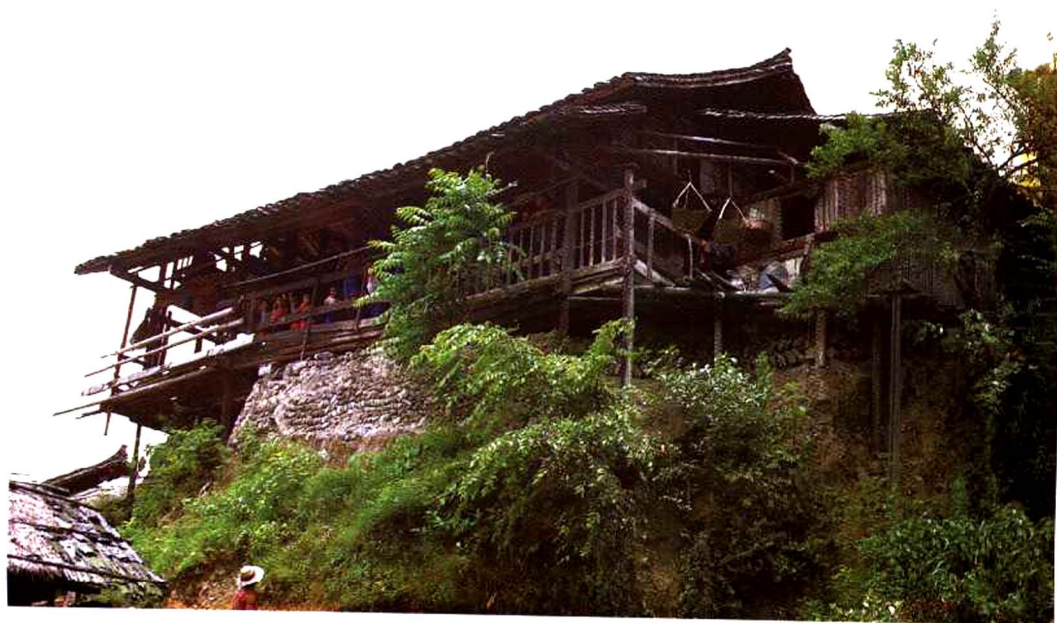
适应复杂地形 的长短吊脚与 悬挑
