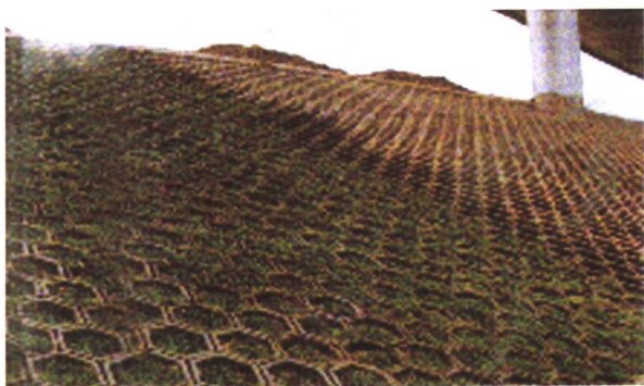
▲ 图 2-3-4 预制混凝土构件砌块护坡
