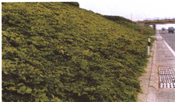
▲ 图 2-3-5(b) 生态护坡
