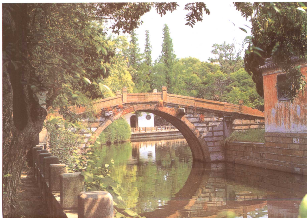
建于南宋的嘉定县孔庙汇龙潭青云桥
