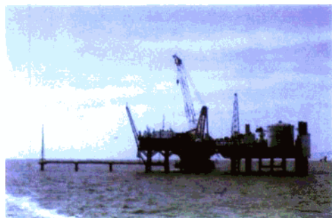
海洋中心一号采油平台
