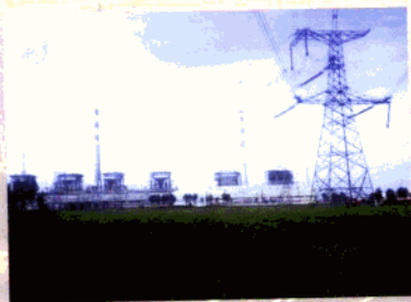
图为装机容量240万千瓦的邹县发电厂
