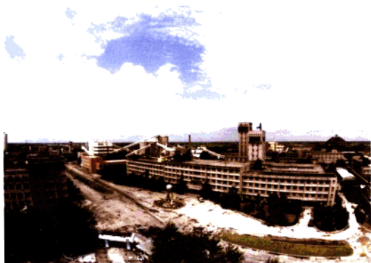
年产超过500万吨的特大型矿井——兴隆庄煤矿
