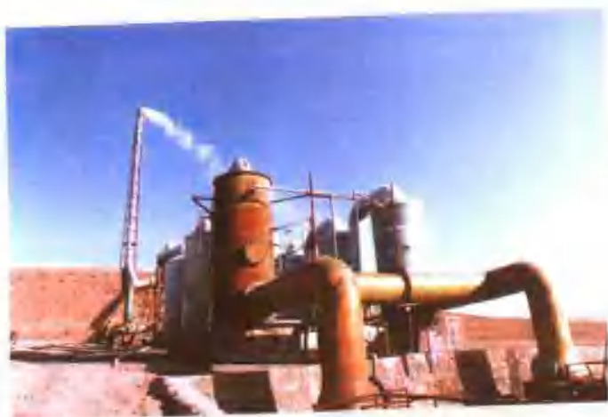
达茂旗稀土矿环境治理 流程设施
