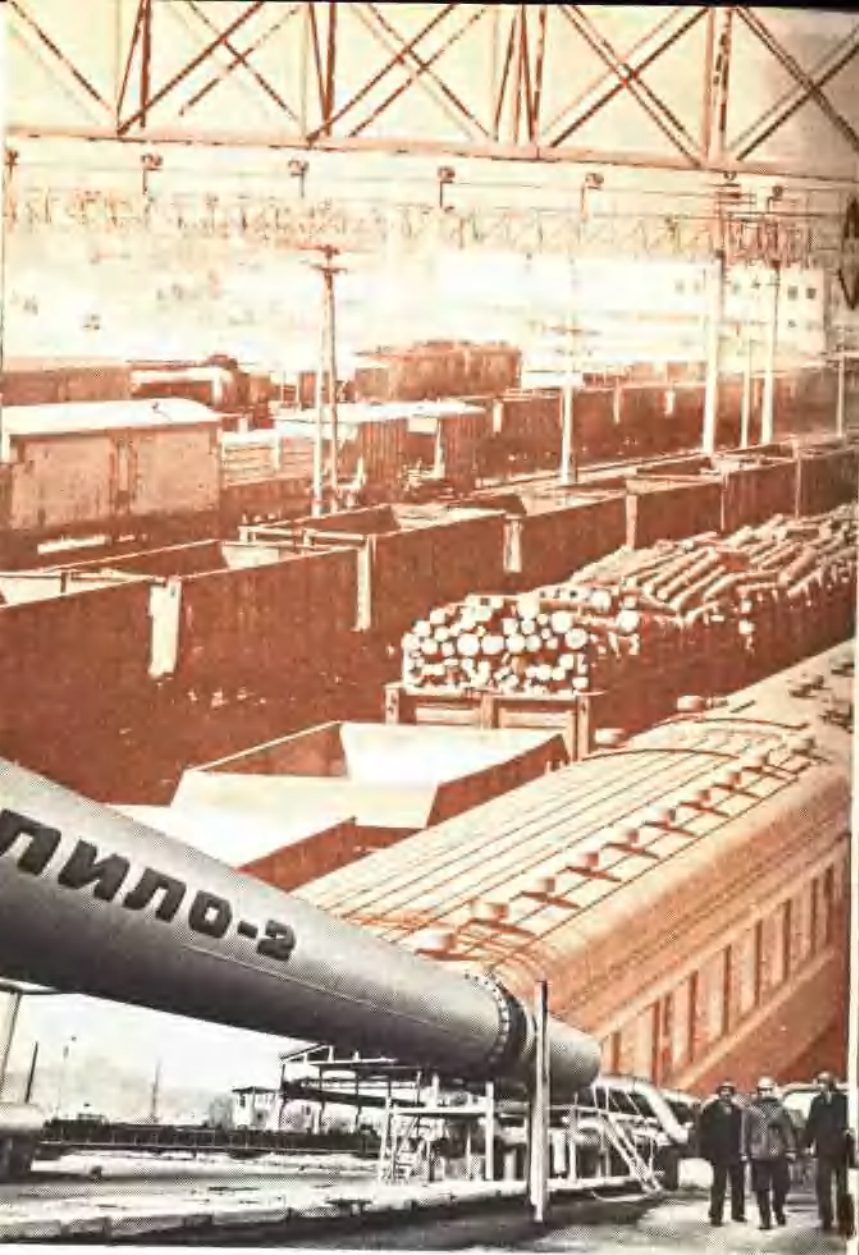
采用新的运输方式。运输固体材料的管道。
