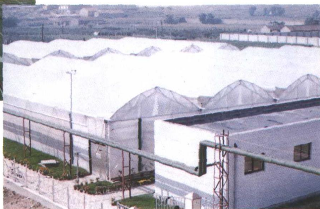
引进现代化温室
