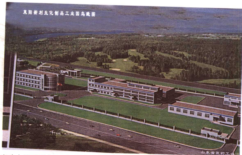
兴建中的新利生化制品工业园
