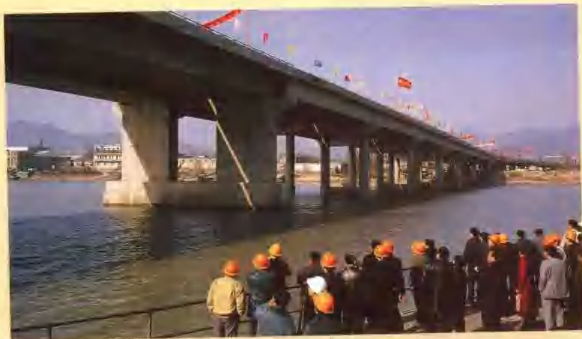
富春江中埠大桥竣工。图为浙江省公路协会的领导和专家参观大桥。
