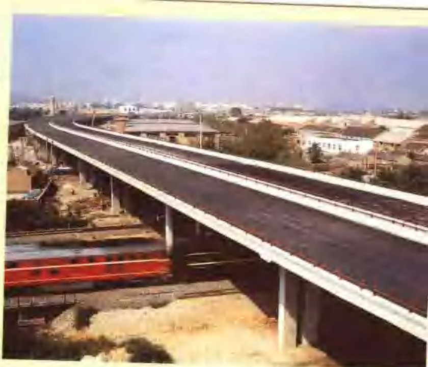
青岛双流高架桥。
