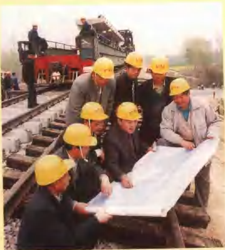
新长线铺轨架梁进入三处管区施工，处长郑修杰（前右2）率工作组临场指导。 （刘考 摄）
