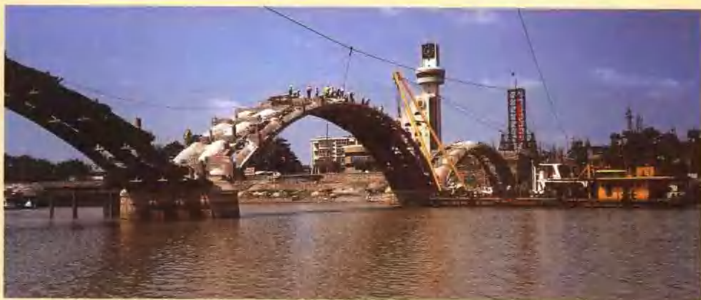
京杭运河邳州高架桥旧桥拆除。
