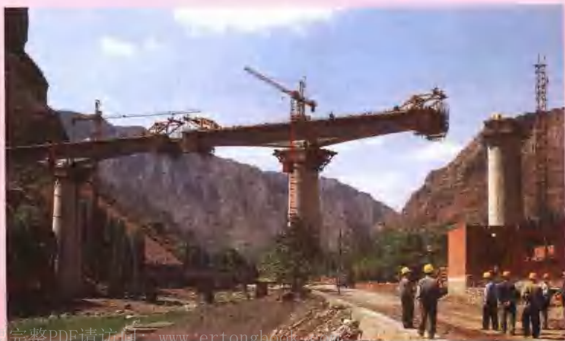
二处承建的朔黄铁路红山崖大桥悬灌梁施工现场 (张阳灿 摄)
