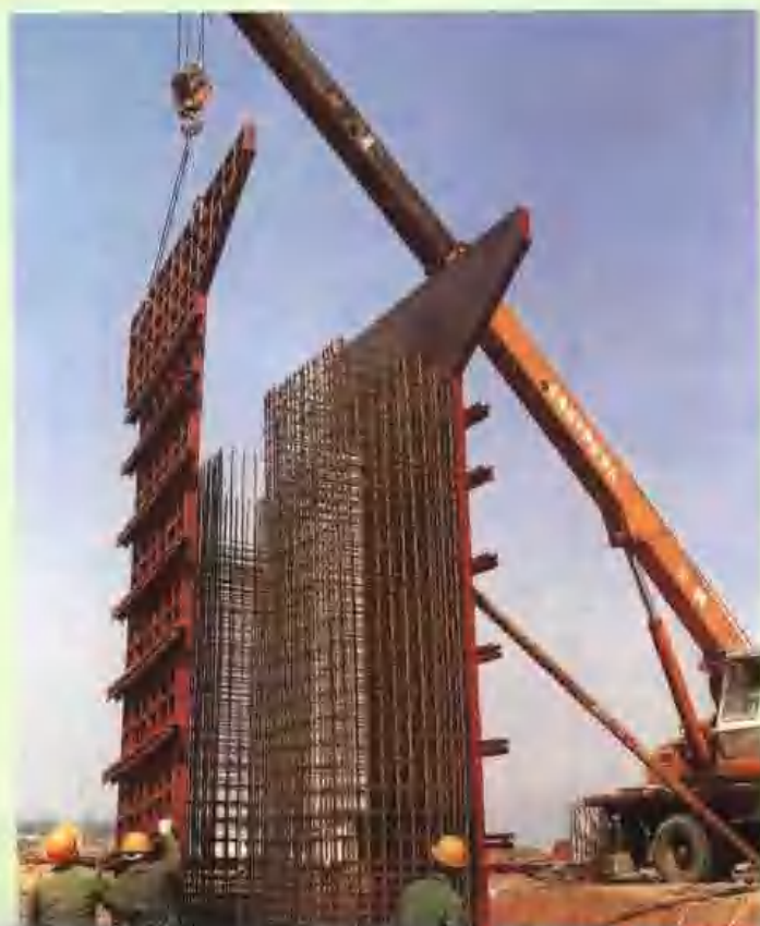
泰曲高速公路桥墩施工采用新工艺——整体模板施工。（王长利 摄）
