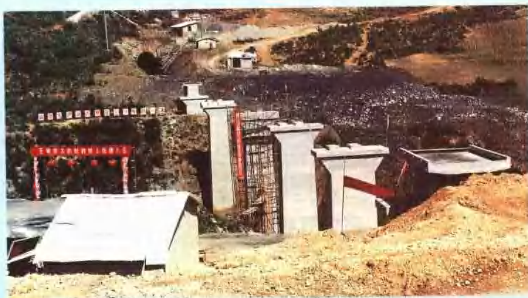
内昆铁路王 家梁子大桥主体 竣工。 (刘考 摄)
