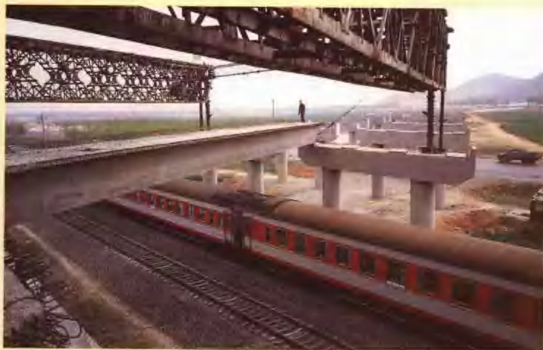
徐连高速公路三堡 立交桥梁施工。
