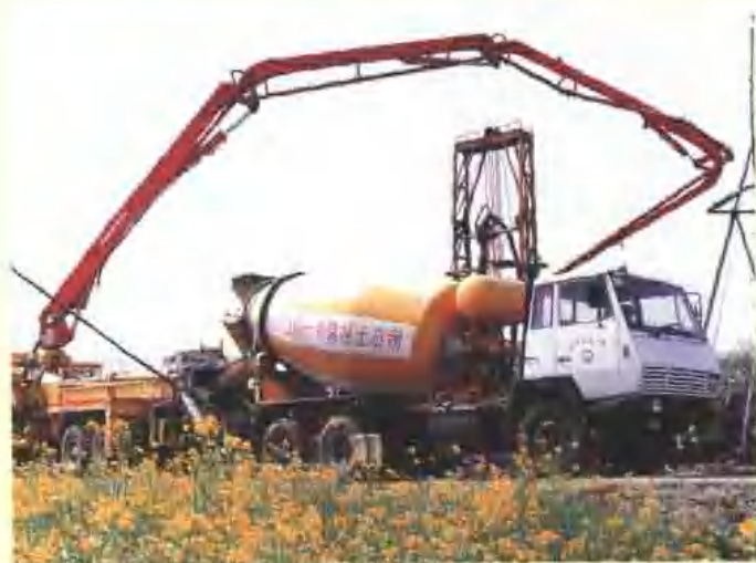
钻孔桩混凝土灌注施工现场。
