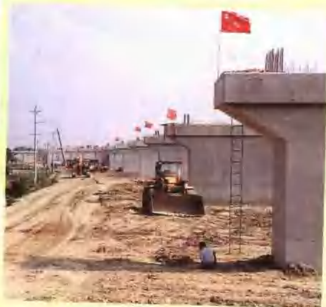
一处承建的芜湖长江大桥引桥 A 标段
