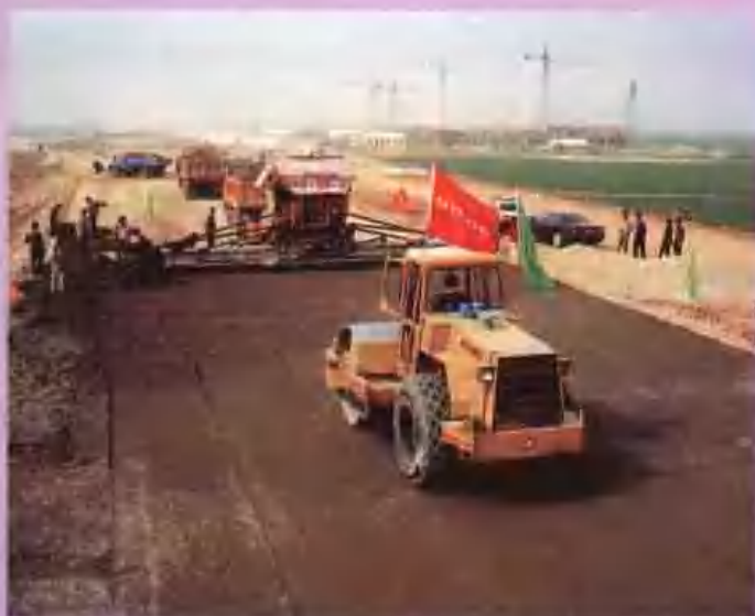
界张高速公路基层摊铺作业。
