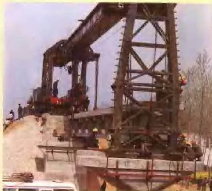
新长线架梁施工。
