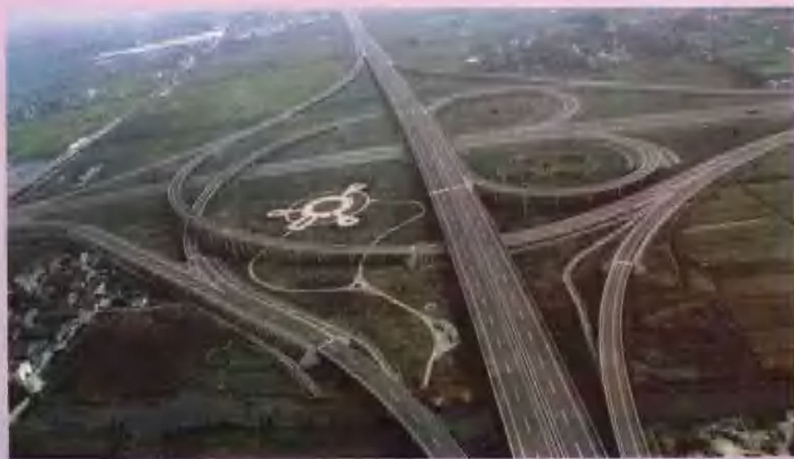
一处承建的宁波同三线潘火立交桥。
