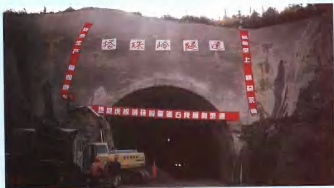
宁波同三线塔珠 岭隧道右线贯通。 (宁波项目部 提供)
