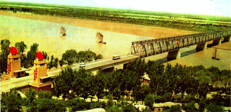
平阴黄河钢桁架桥
