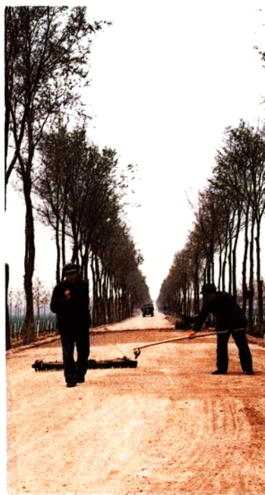
路面松散保护层回匀砂
