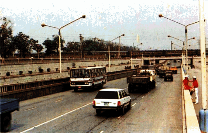
张店东公路与铁路立体交叉
