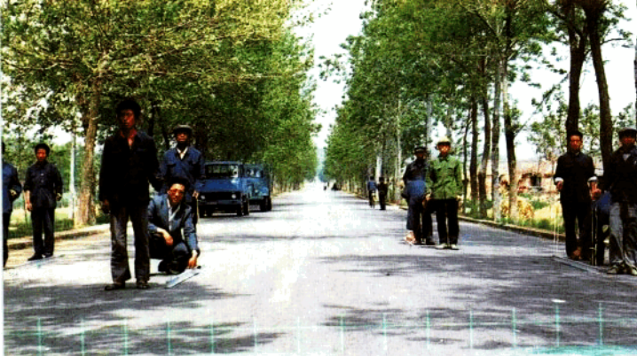
用直尺量验路面平整度
