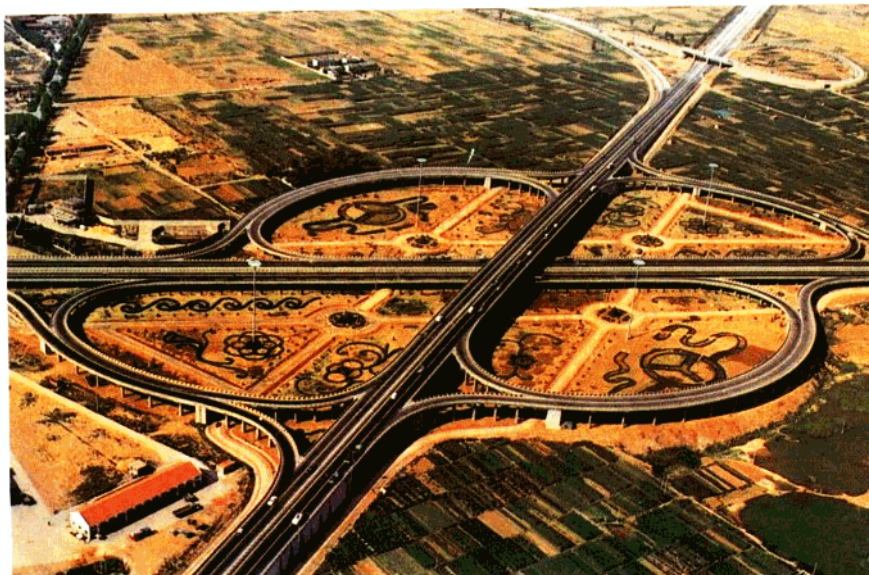
青岛市流亭公路与公路立体交叉
