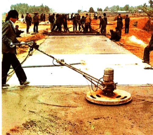
水泥混凝土路面磨平
