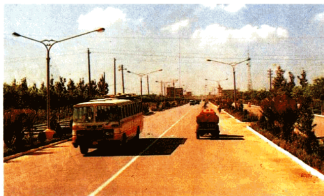
烟台—汕头国道 莱州城区一级路
