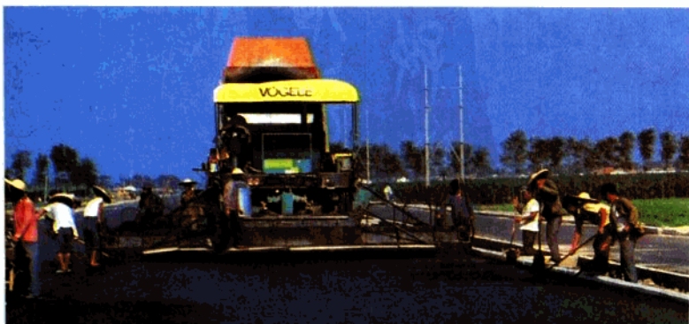
沥青混凝土路面面层摊铺
