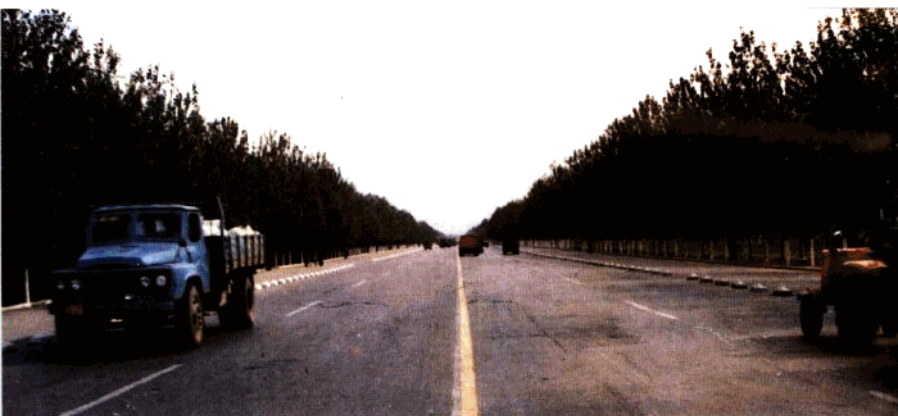
滨州—郑州国道段店周王庄段一级路
