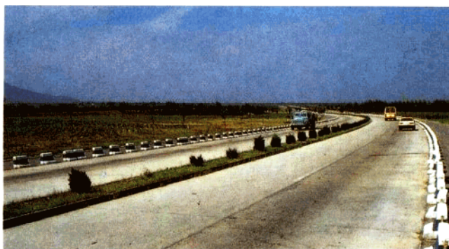
北京—福州国道 曲阜市境一级路
