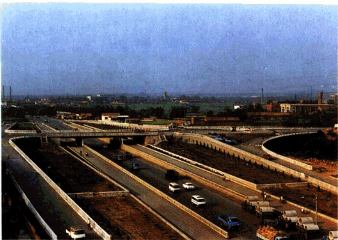
淄川公路与公路立体交叉
