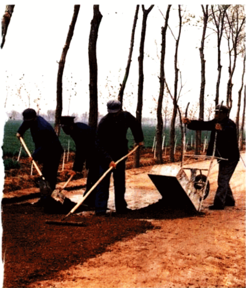
铺筑路面磨损层
