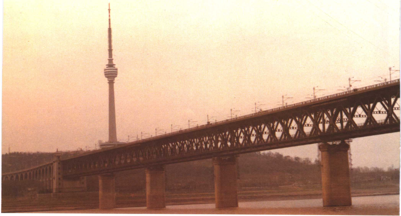
武汉长江大桥
