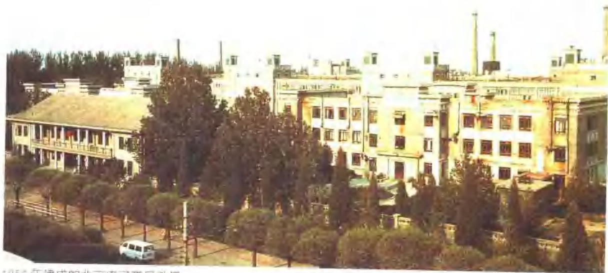
1956年建成的北京电子管厂外景
