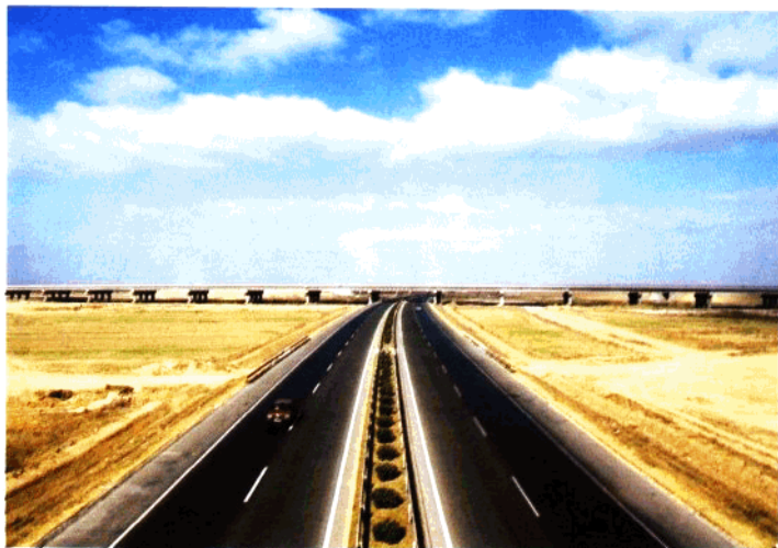
与济青高速公路相交的潍莱高速公路上最大的互通立交桥——涌泉互通立交桥
