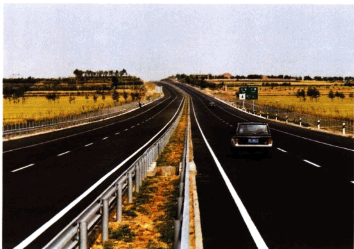
建成通车的潍莱高速公路
