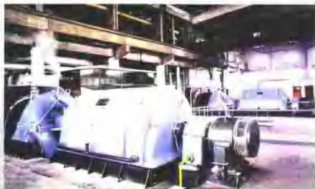
煤矸石电厂 2 \times 6000\text{kW} 汽轮发电机组
