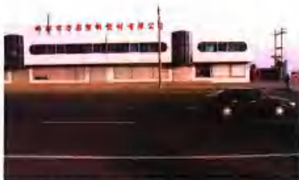
方圆塑钢型材有限公司办公楼近景
