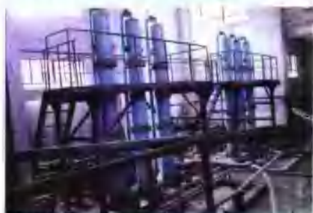
尾矿输送系统一角——水隔离泥浆泵
