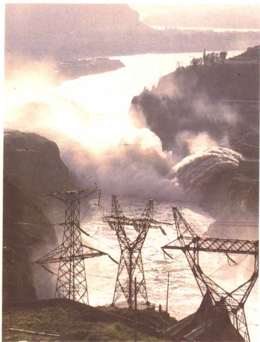
刘家峡水电站
