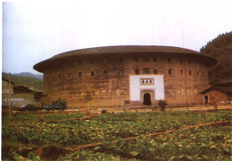
永定土楼外景
