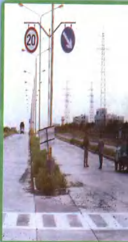
独山子炼油厂乙烯厂厂区公路
