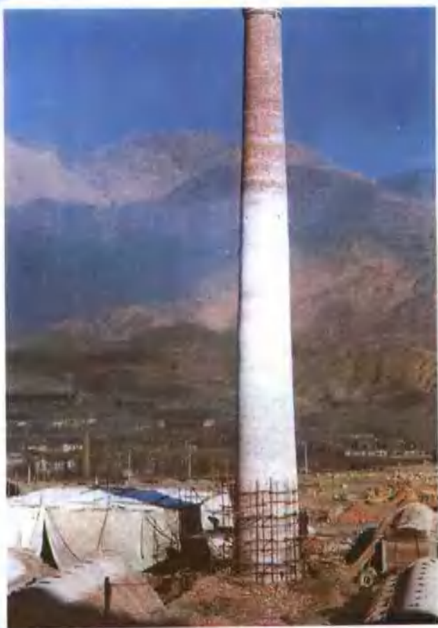
艾维尔沟煤矿封闭式炼焦厂施工场面
