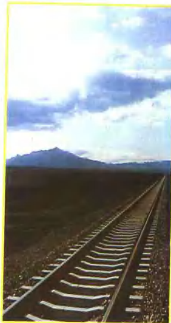
自治区重点工程艾维尔沟铁路支线 (优良工程)
