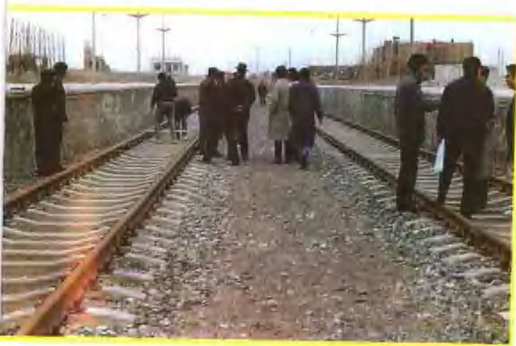
博州粮食局精河中转库铁路专用线(优良工程)
