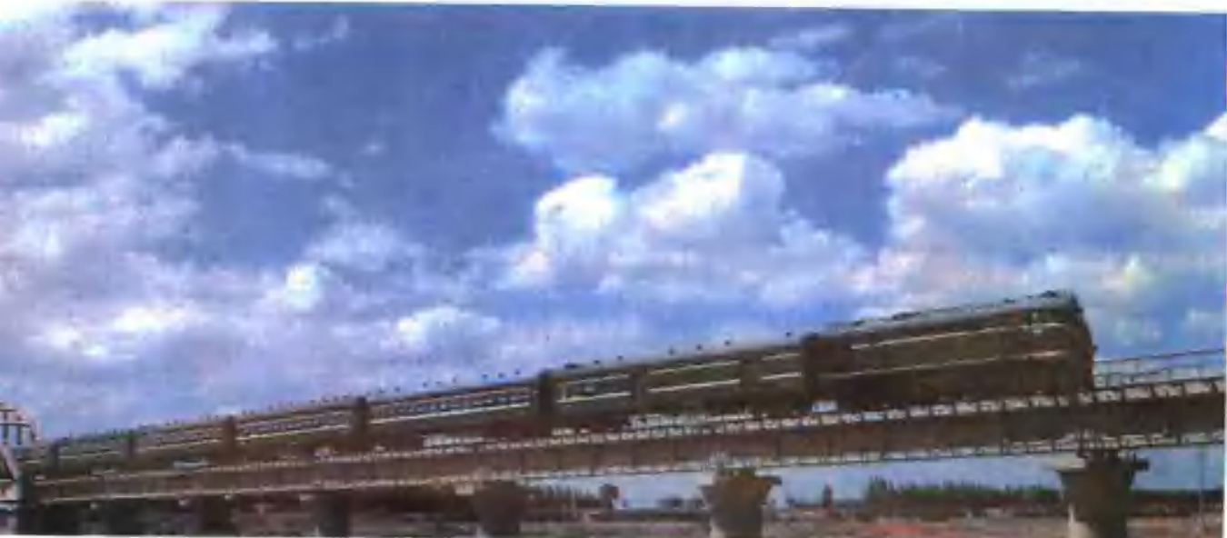
雄伟壮观的昌吉大桥 其中大桥顶升难度为新疆建桥中之最
