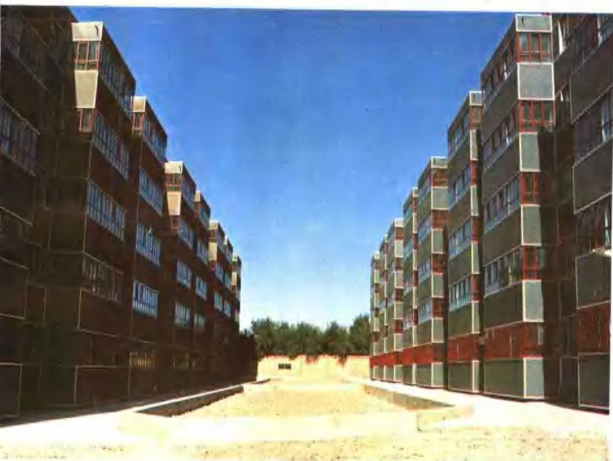
「二团自建住宅楼(优良工程)」
