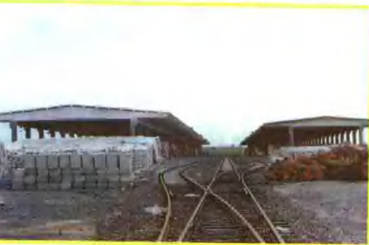
兵团奎屯储运公司铁路专用线(优良工程)
