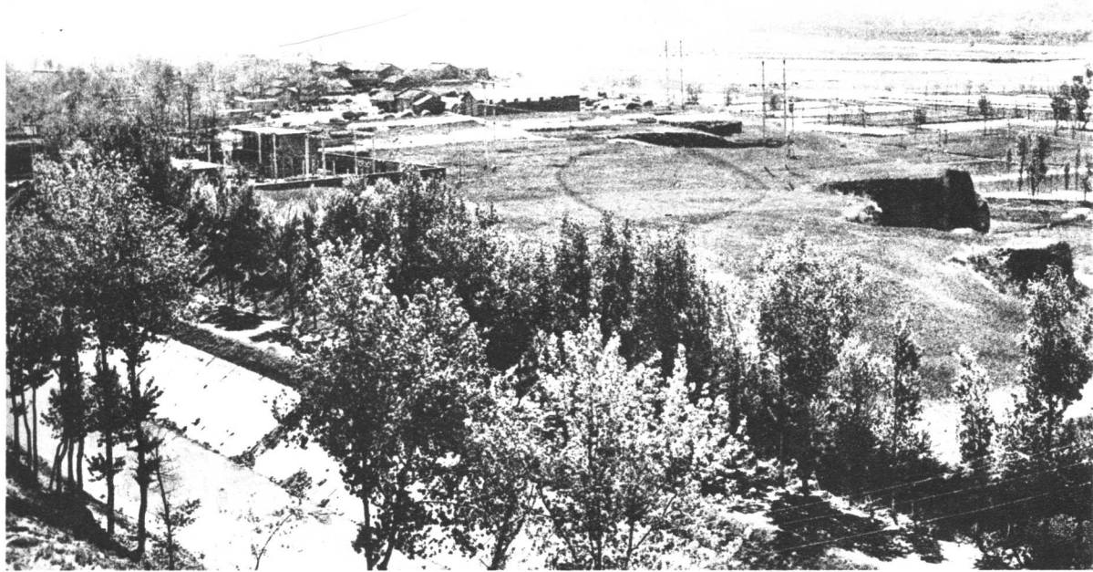
左侧小楼处为 I 区，中上部平房处为 II 区 (由西北向东南摄)
