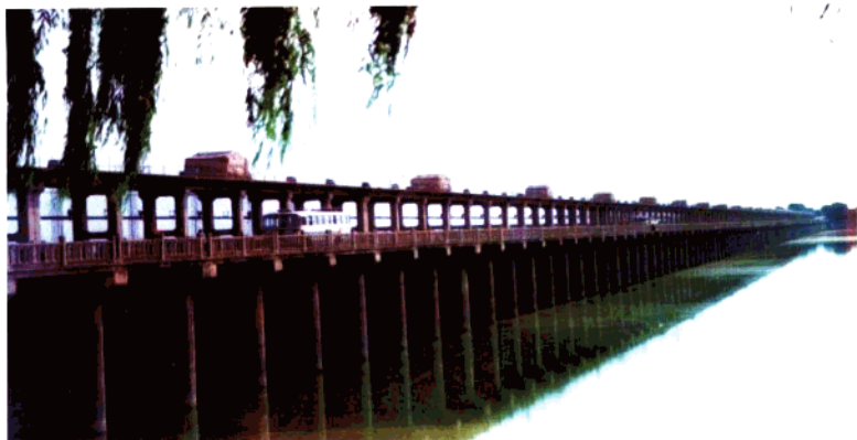
南四湖 二级坝四闸
