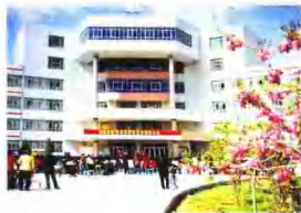
设备完善、功能齐全的综合教学大楼
