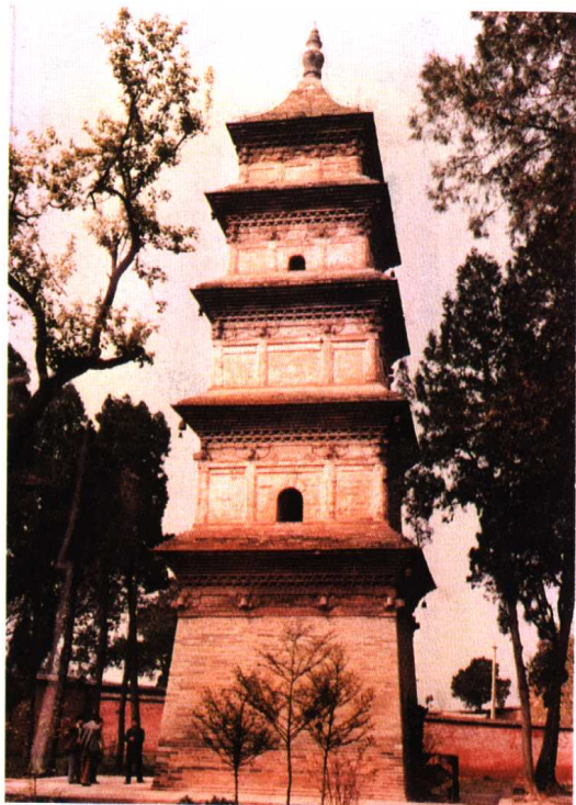
西安兴教寺玄奘舍利塔
