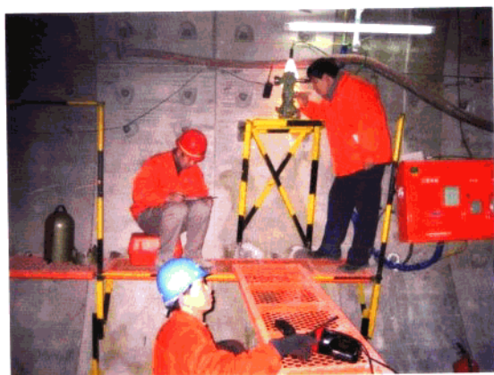
隧道贯通测量
