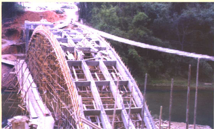
老区铁索桥改造施工现场。
