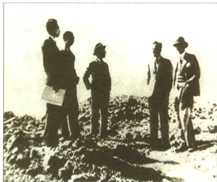
▶技术人员勘察地形
