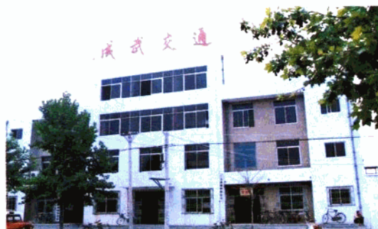
交通局办公楼
