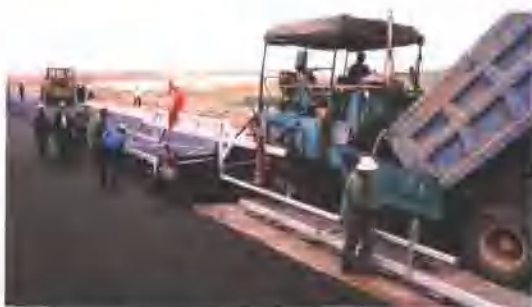
现代化的沥青摊铺机铺筑高质量的现代公路
