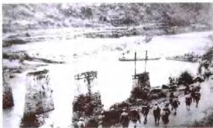
敌匪烧毁的妙泉大桥
