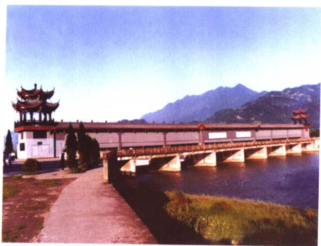
新建的都江堰工业引水 临时拦水闸
