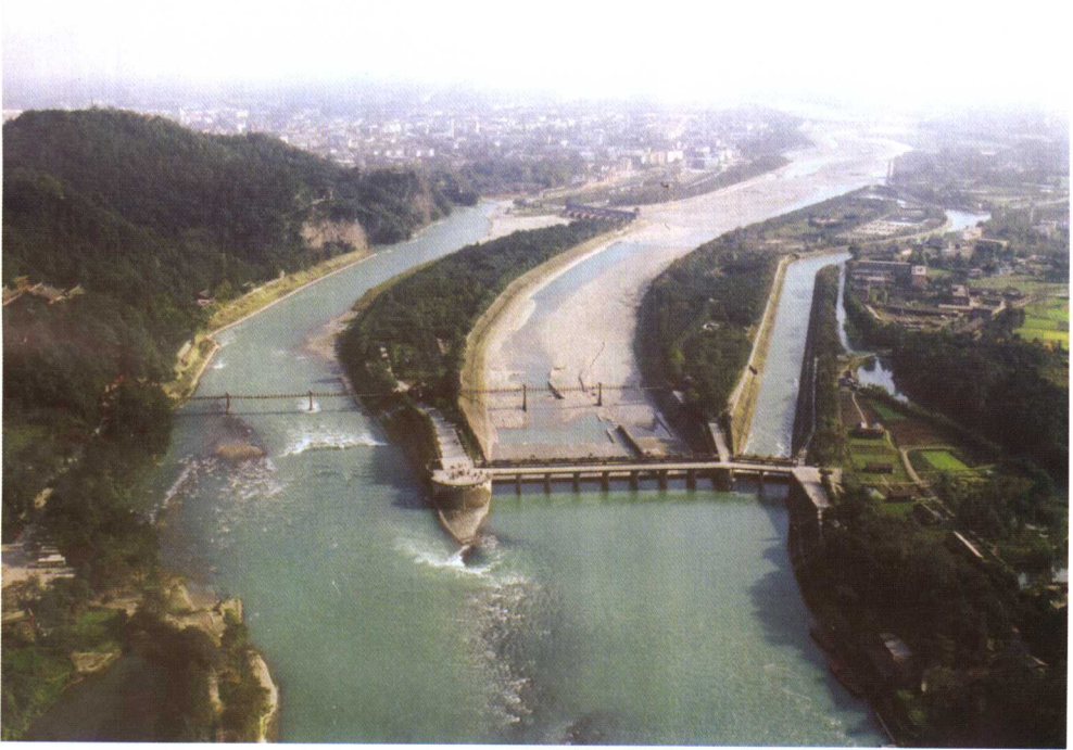
都江堰渠首工程全景
