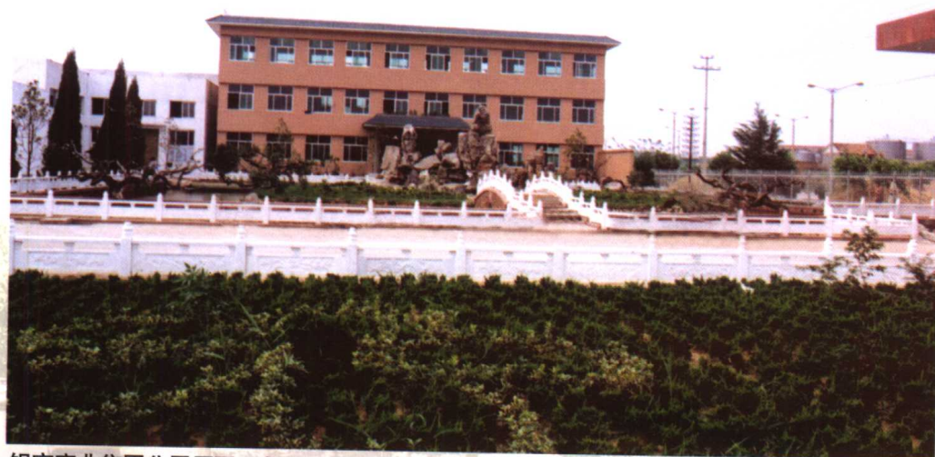
银宝实业集团公司厂区一角
