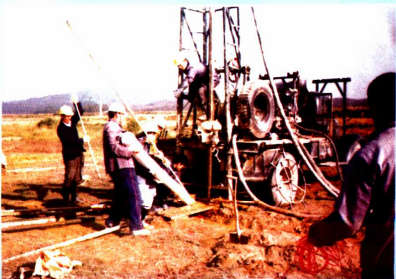
人工地震（爆破）
