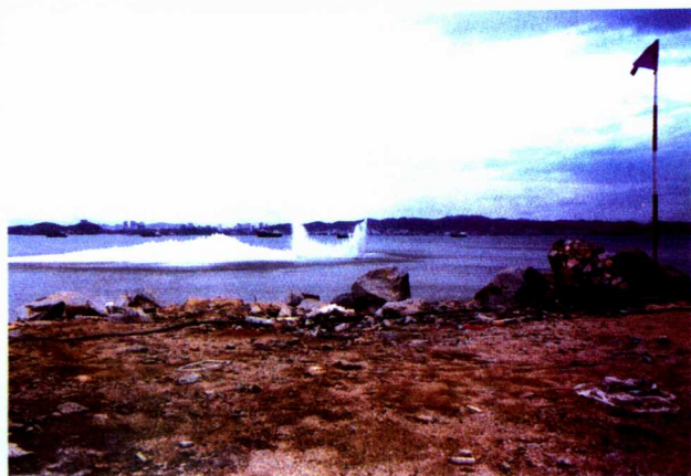
漳州港夯量测试
