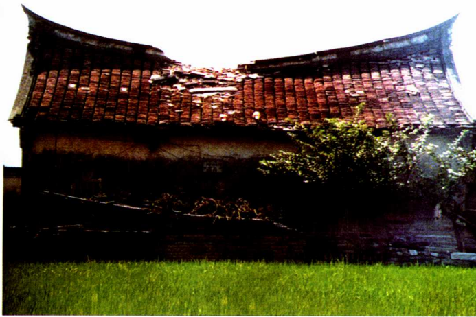
1994年9月16日台湾海峡南部发生7.31级地震，有感范围广、福建南部地区最大影响为六度。上、下两图为被破坏的闽南一座房的正、反面
