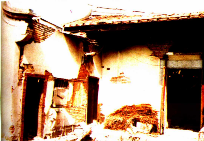
1994年9月16日台湾海峡南部发生7.31级地震，有感范围广、福建南部地区最大影响为六度。上、下两图为被破坏的闽南一座房的正、反面
