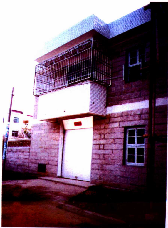
位于漳浦县的石结构抗震示范房
