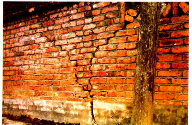
1997年5月31日永安西南发生5.2级地震，图为双洋镇水泥厂倒塌的厂房(左)和永安吴岭村小陶镇民房墙体(右)
