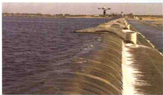
亚洲最长的橡胶坝——临沂小埠东橡胶坝近景
