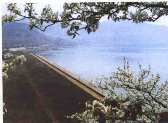
除险加固后的许家崖水库
