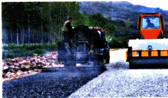
县乡公路建设现场
