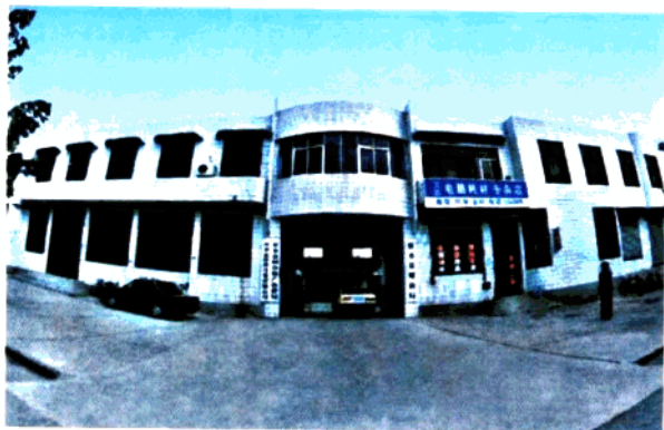
局机关办公楼一角
