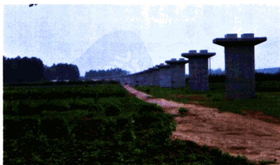
胶新铁路沂水境内最长的特大桥 ——黄花河特大桥桥墩
