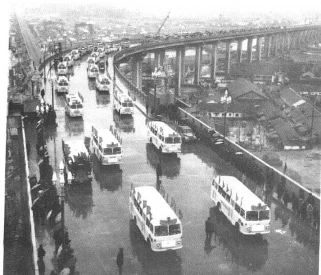
公路桥通车 (大桥工程局供稿)
