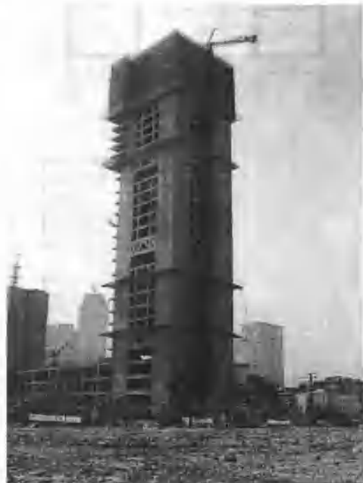
图2 施工时的全景
