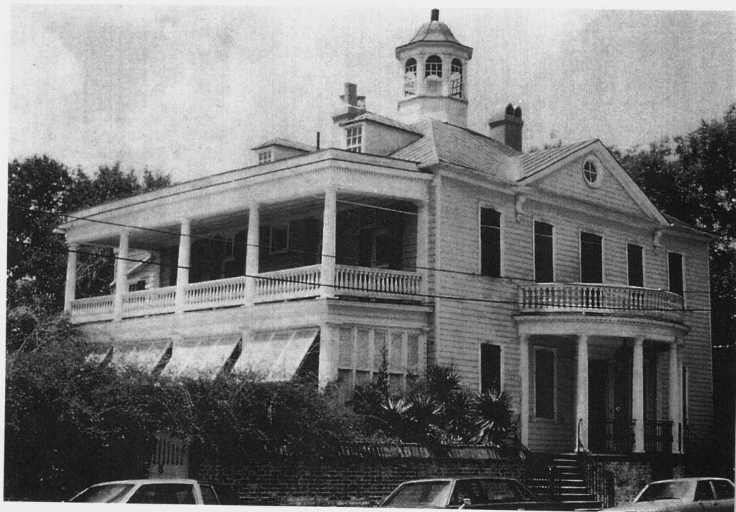
图 1.2b 在湿热地区，通过附遮阳设施的窗进行的自然通风是达到舒适温度的最有效途径。在图中南卡罗来纳州查尔斯顿市的住宅中，带挑檐的门廊和对窗户起到遮阳作用的阳台带来了凉爽的室外空间。房屋的白色和屋顶上的通风孔都对酷热的夏季降温有重要作用
