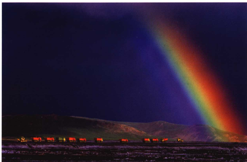
路基土方施工
