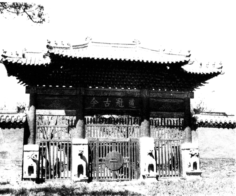
道冠古今坊 明永乐十三年（1415年）建，与“德侔天地坊”同为孔庙的第一道东西向偏门，清光绪三十四年（1908年）改为黄色琉璃瓦顶。
