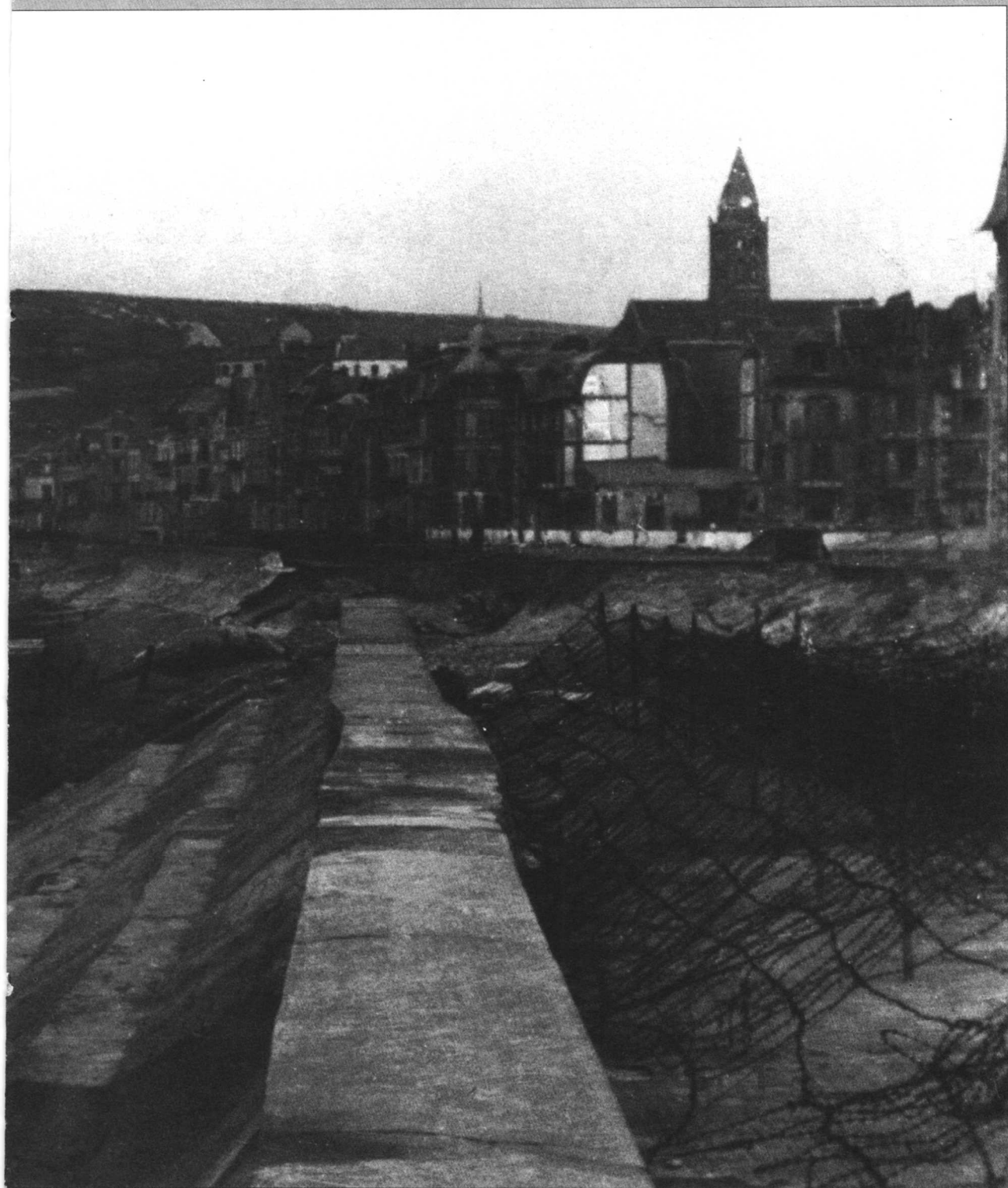
大西洋防御墙——海滩障碍物,隐藏的炮兵连以及被炸弹毁坏的海墙后面那些纠缠在一起的铁丝网——保卫着法国海边一个小镇。
