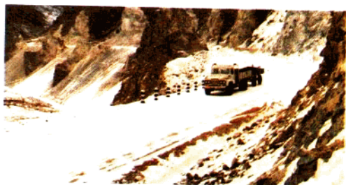
1987年承建的延吉市五道沟水库公路改线工程
