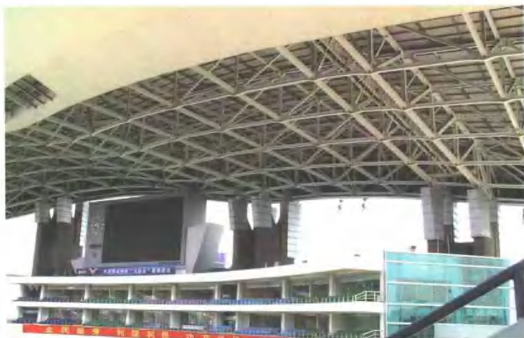
钢屋盖的10 013根杆件，互不通用，三维坐标均不相同
