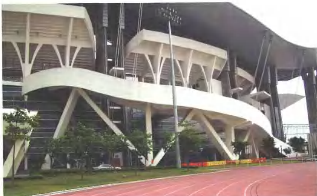
“V”形柱托起百米弧形大楼梯
