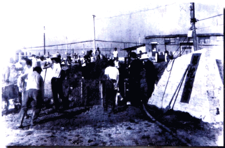
主井破土动工
